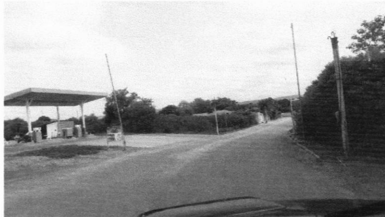
INICIO DO TRECHO DA AVENIDA MODESTO ANTONIO
