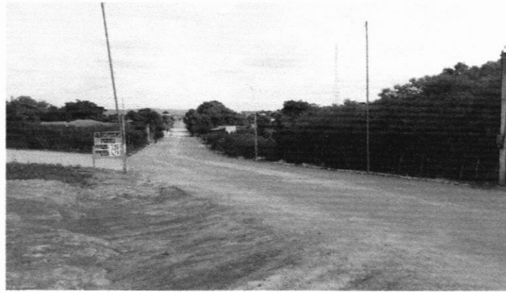
INICIO DO TRECHO DA AVENIDA MODESTO ANTONIO
